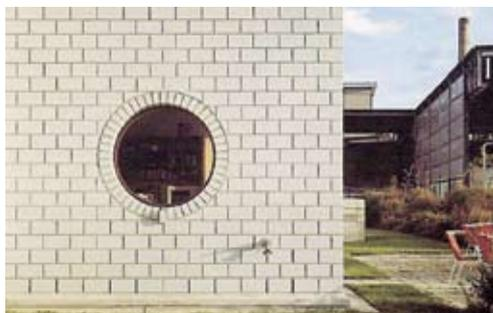
**Handwerkgerichtetes Sichtmauerwerk** kann nicht exakt wie ein Präzisionselement ausgeführt werden.
